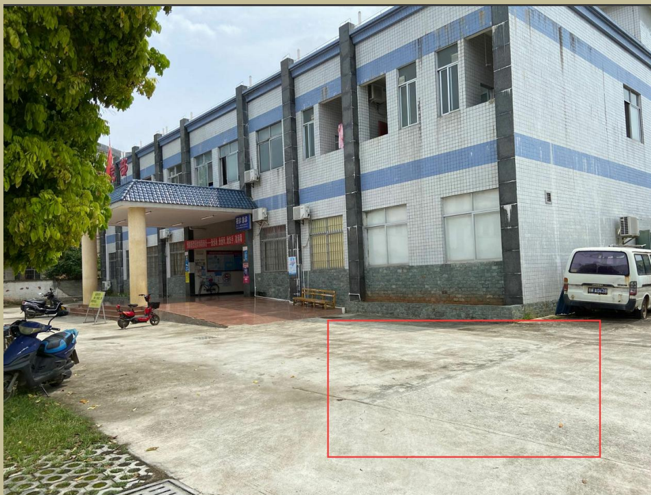
图 1 拟建污水处理设施周边现状情况
