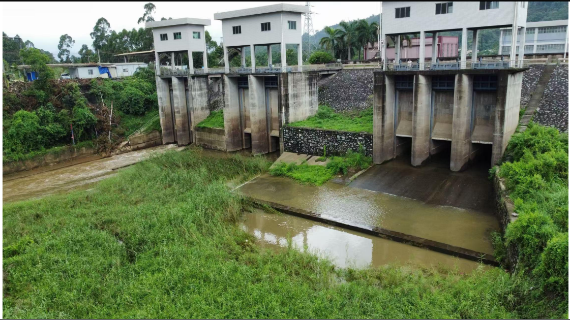
图 2-4 蓬远水闸现状图
