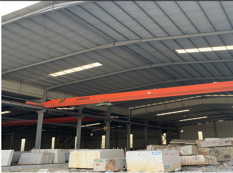
图 2-7 厂房屋顶堆放石材荒料和成品
